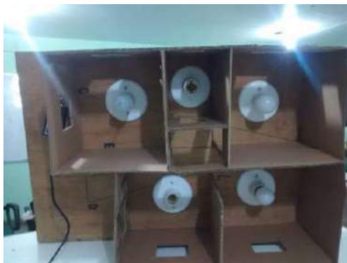
Figura 05: Vista dos bocais das lâmpadas e circuito elétrico.
